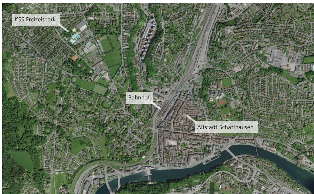
Abbildung 1: Der KSS Freizeitpark im nordwestlich des Bahnhofs gelegenen Quartier Breite in Schaffhausen.
